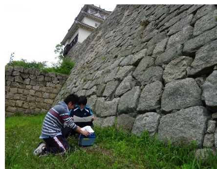
丸亀城石垣部での常時微動測定
